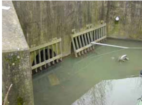
010 Ketley Brook DS Culvert DS A518 Holyhead Road
