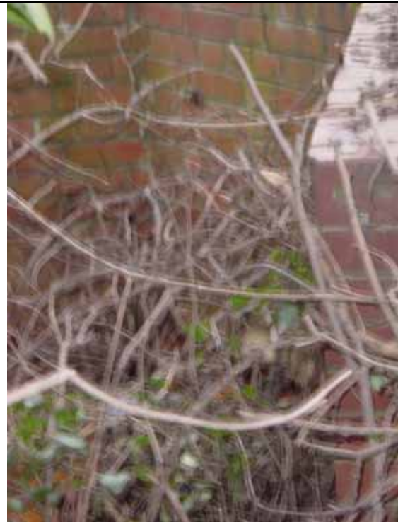
053 Crow Brook DS Culvert Sommerfeld Road
