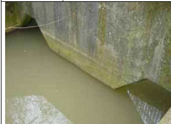
005 Ketley Brook Culvert DS M54 Blind DS
