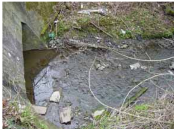
034 Hurley Brook DS Culvert Leegate Avenue
