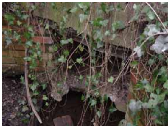
066 Crow Brook DS Culvert nr Horton Lane
