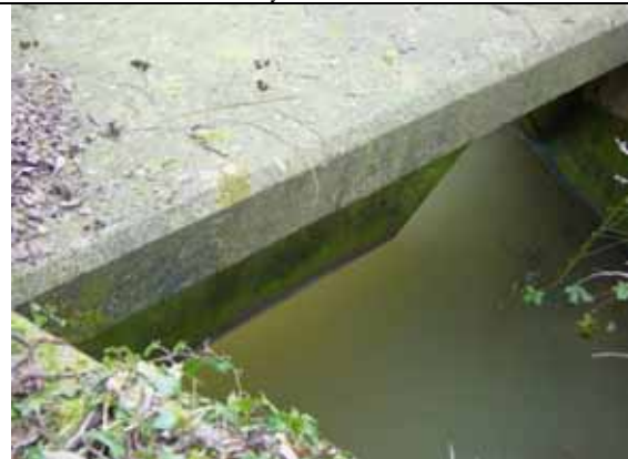
004 Ketley Brook Culvert DS M54 Blind US
