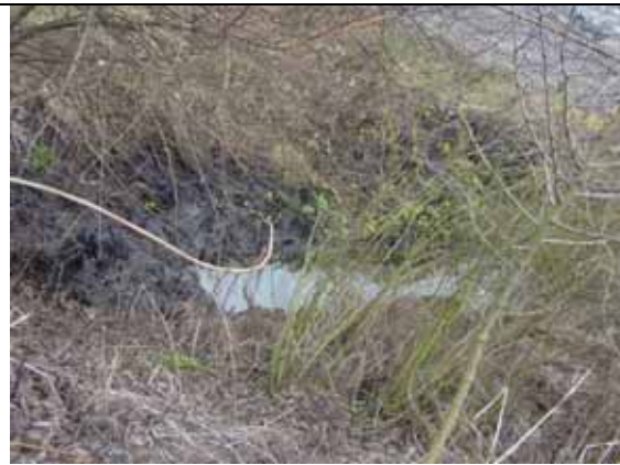
039 Hurley Brook DS US Culvert nr Arleston Lane
