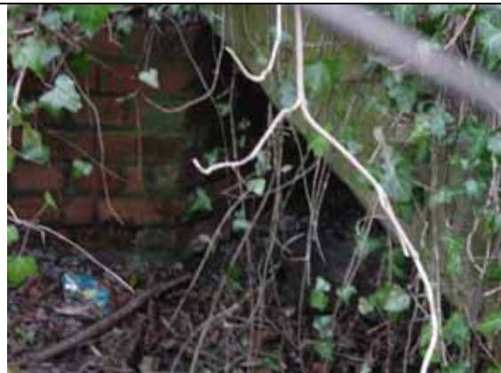
068 Crow Brook US Culvert nr Horton Lane
