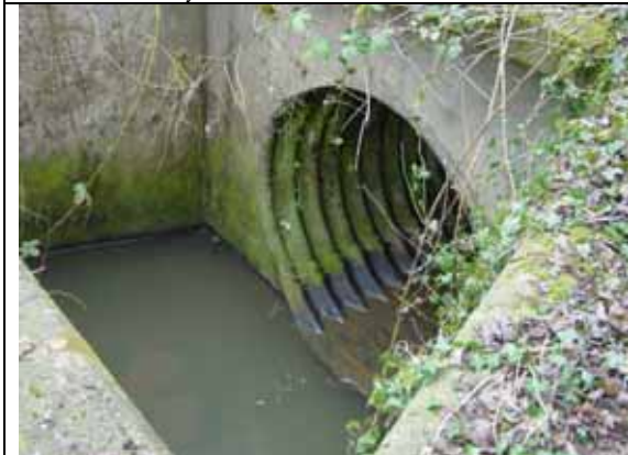
003 Ketley Brook Culvert DS M54
