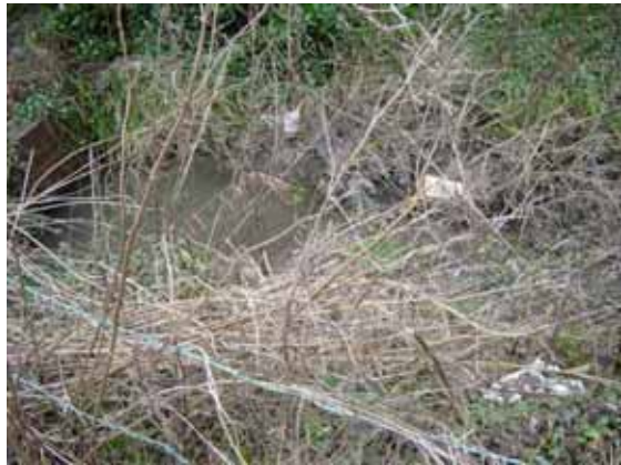
047 Crow Brook DS Culvert Hadley Road
