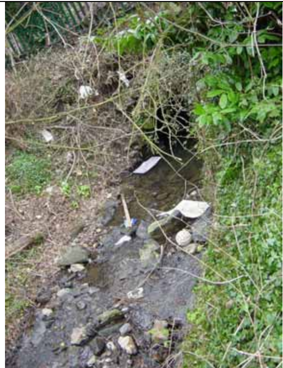
046 Hurley Brook DS Culvert Limekiln Lane
