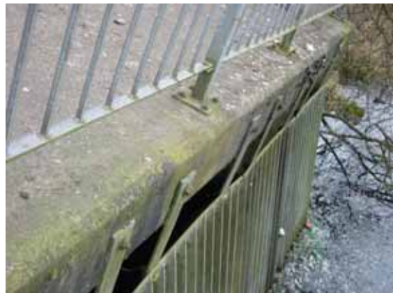
058 Trench Pool DS Overflow
