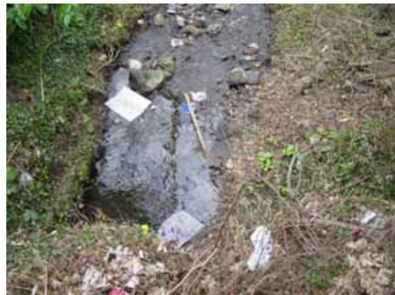
045 Hurley Brook DS Culvert Limekiln Lane
