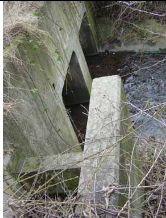
031 Hurley Brook DS Culvert A442 Queensway
