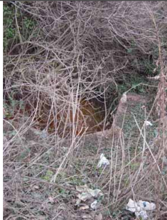
051 Crow Brook DS Culvert Sommerfeld Road
