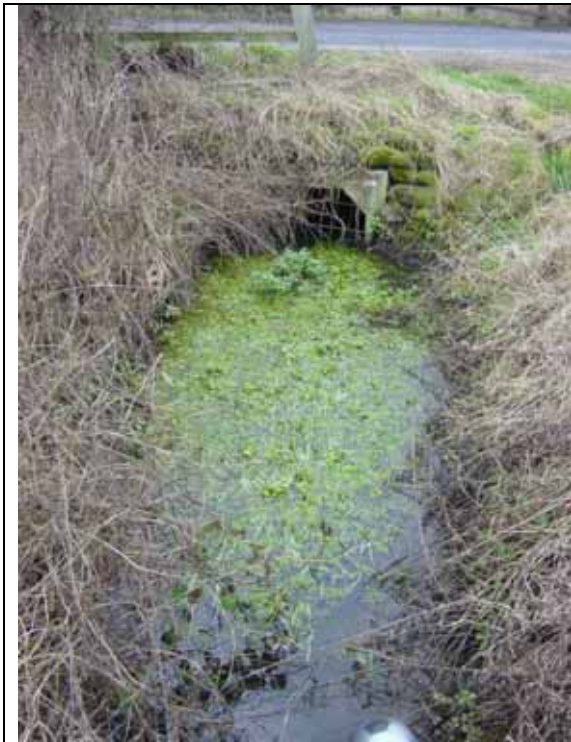
069 Crow Brook DS Culvert Humber Lane
