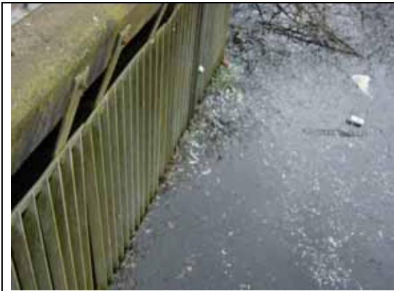
059 Trench Pool DS Overflow
