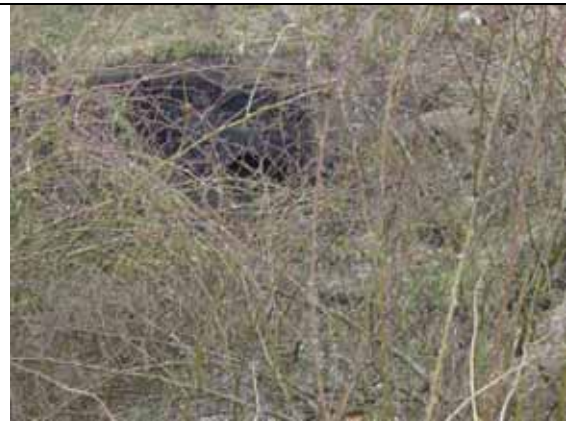
040 Hurley Brook US DS Culvert nr Arleston Lane
