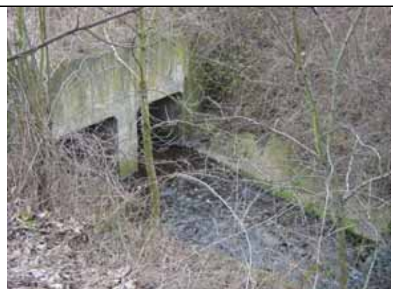
030 Hurley Brook DS Culvert A442 Queensway
